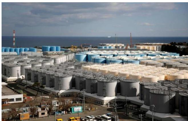
福島第一核電廠用來存放核廢水的大型鋼罐
